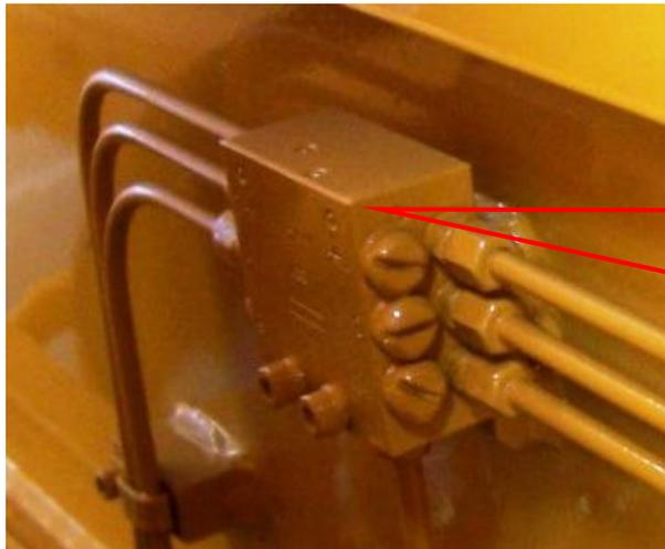
该处指针如长期溢出，请立即拆开其对应油管，工作完毕后立即对堵塞润滑点进行清理疏通
