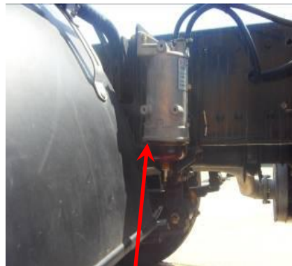
更换燃油粗滤器,并定期放水
