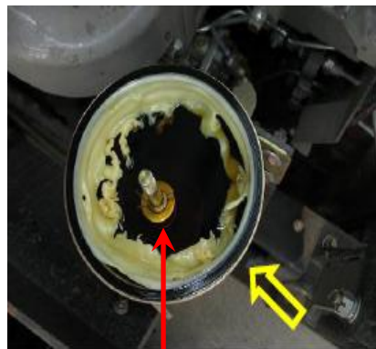
换油时同时更 换滤芯
