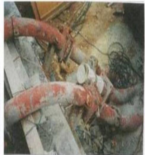
在高140m的32楼层，布置了27.8m水平管、90°弯管3个；如32层水平图示
