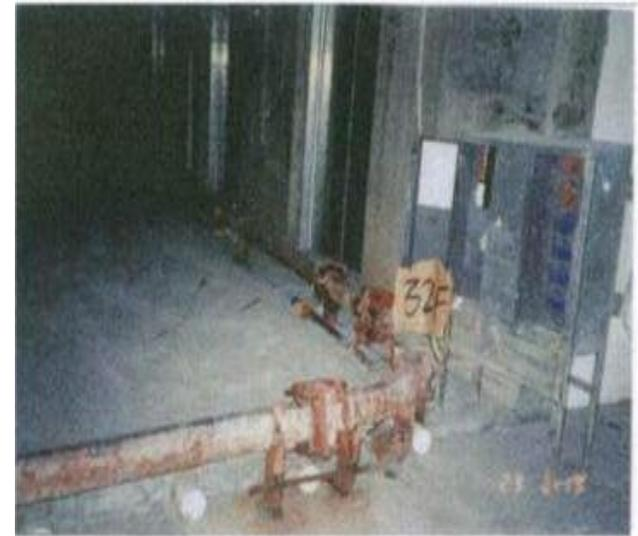
在高200m的46层布置90°弯管2个；在高240m的55层布置90°弯管2个；然后一直往上，全长622m。直管两端都用刚性支撑固定牢靠。
