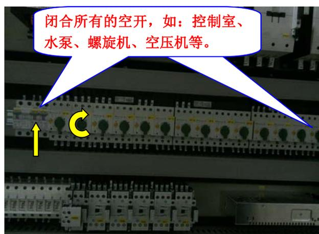
2、打开机械锁，闭合操作台电源，按下空压机启动按钮，启动空压机。
