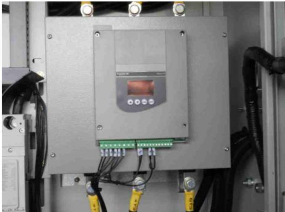
当电机功率超过132Kw时，使用软启动，以避免电网的冲击，保护电机。
